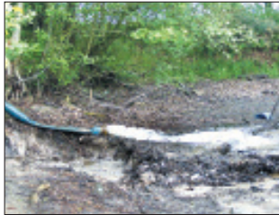
Über einen Schlauch wird Grundwasser von der Pipeline-Baustelle in den Angelteich gepumpt. Foto: si
